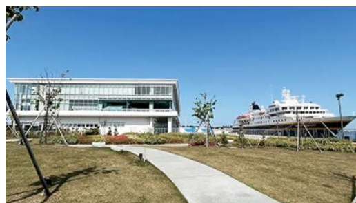
写真-5 金沢港クルーズターミナル
