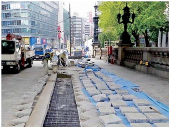
写真-6 舗石の復旧
