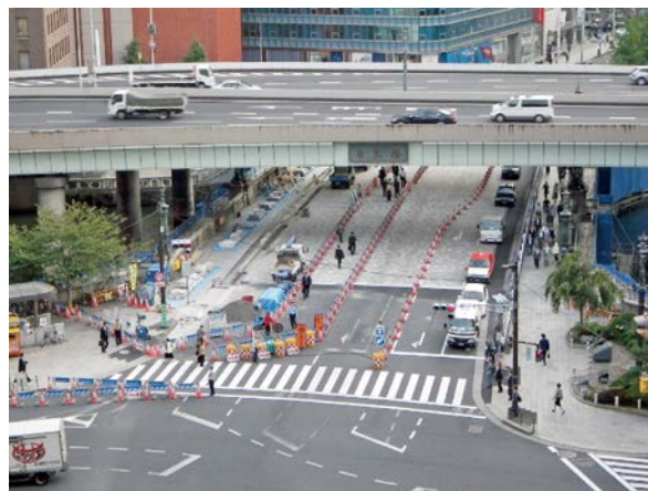
写真-7 常設帯による車線規制
