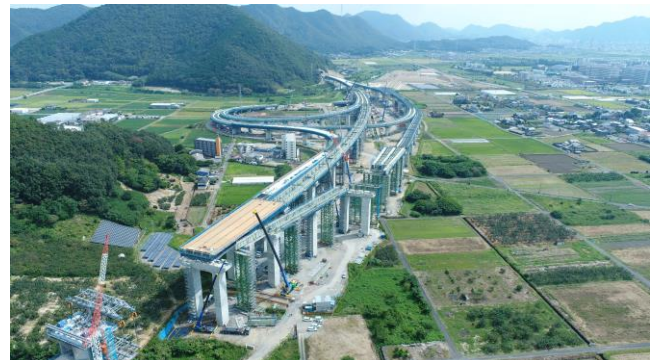
図 5 東海環状自動車道西回り 岐阜 IC(仮称)付近
