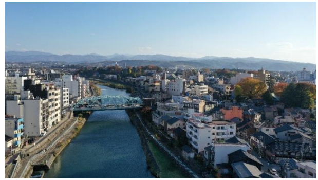
写真2 犀川大橋と寺町台
