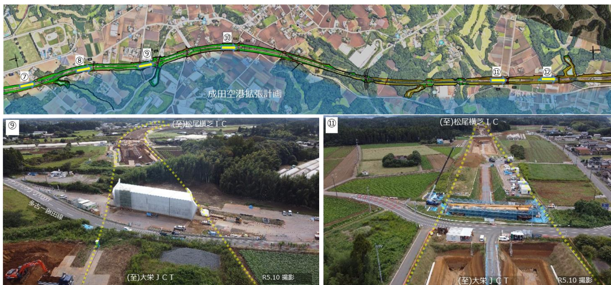
図2 成田空港拡張事業と接して進む千葉圏央道事業
