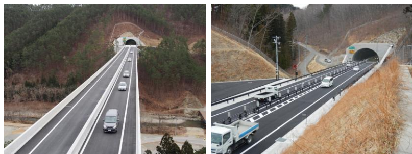
図7 完成2車線道路の「中央分離帯」設置状況
