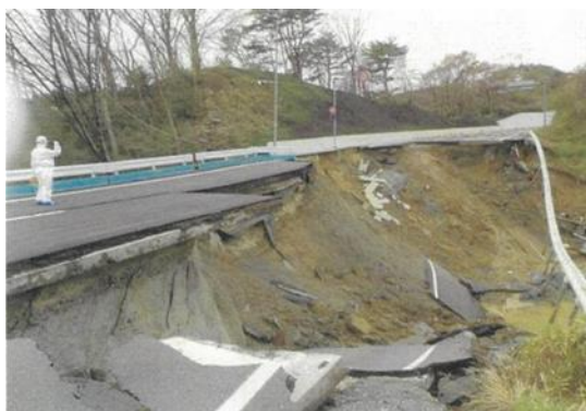
図7 盛り土崩壊（富岡町郡山） (出典：東北地方整備局資料)
