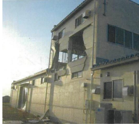
図6 被災した原町国道維持出張所 (出典：警城国道事務所)
