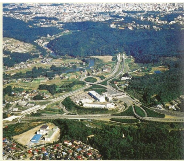
図-6 仙台宮城インターチェンジと仙台市中心部を直結する仙台西道路 (出典:「Next Way」建設省道路局)
