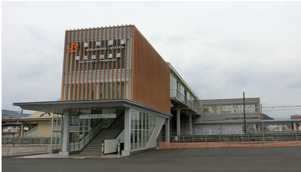
▲新所原駅自由通路外観(南口)
