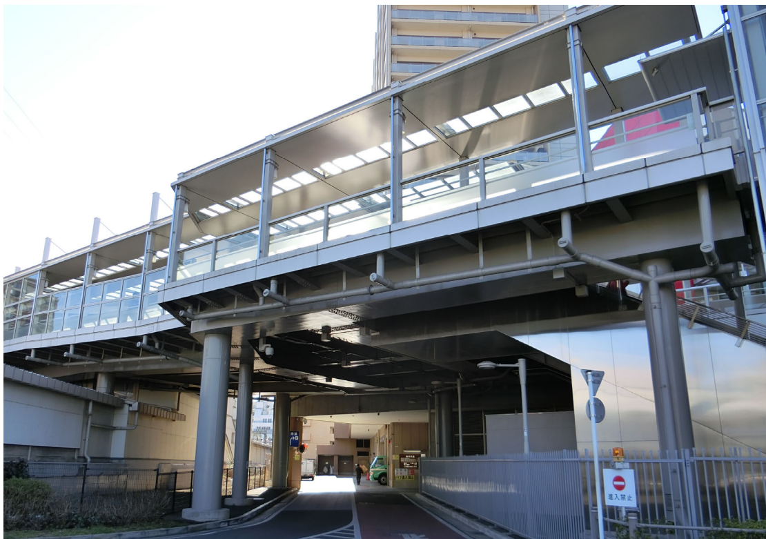
▲小田急相模原駅 歩行者専用デッキ外観
