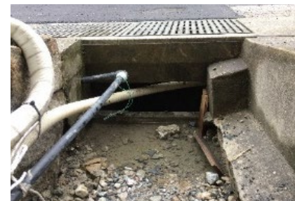
【整備後:側溝横断面部】
