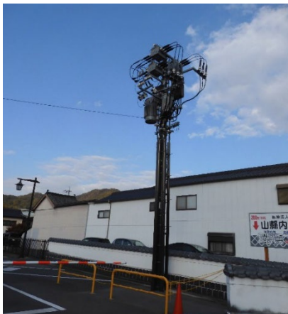
【配置場所を工夫した変圧器】
